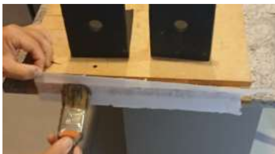
Reforzamiento de lomo
