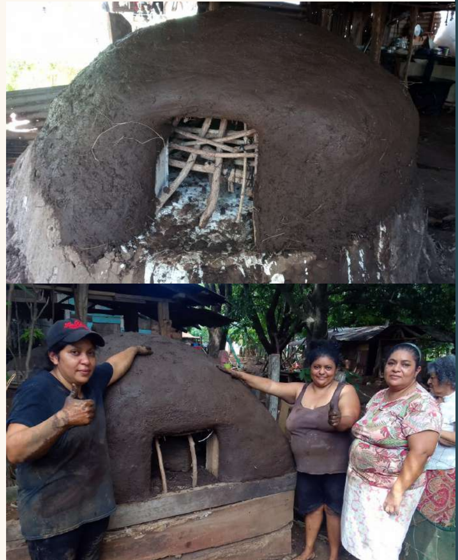
Horno de barro en proceso de construcción en el distrito de Palmira
