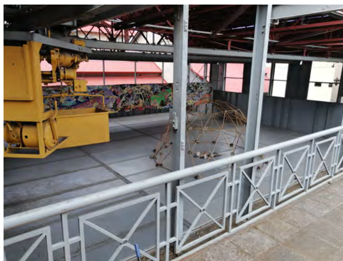
Figura #18. Instalación realizada en el tanque de la Melaza, febrero de 2023.
