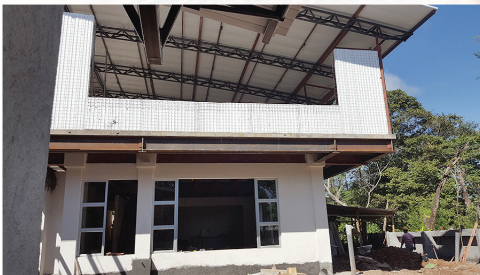
Construcción de la Biblioteca de Puriscal (San José).
